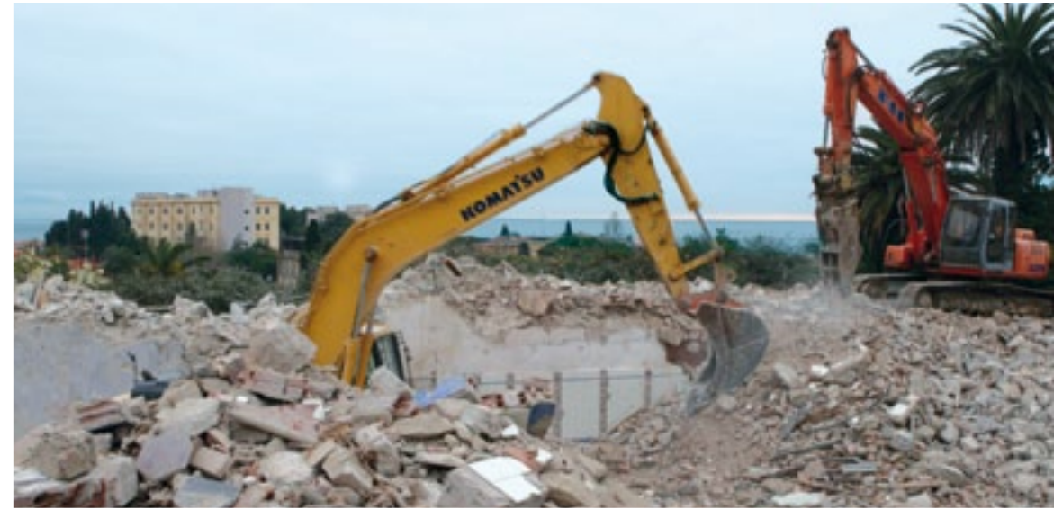
Demolizione Colonia Oberdan - Pietra Ligure
