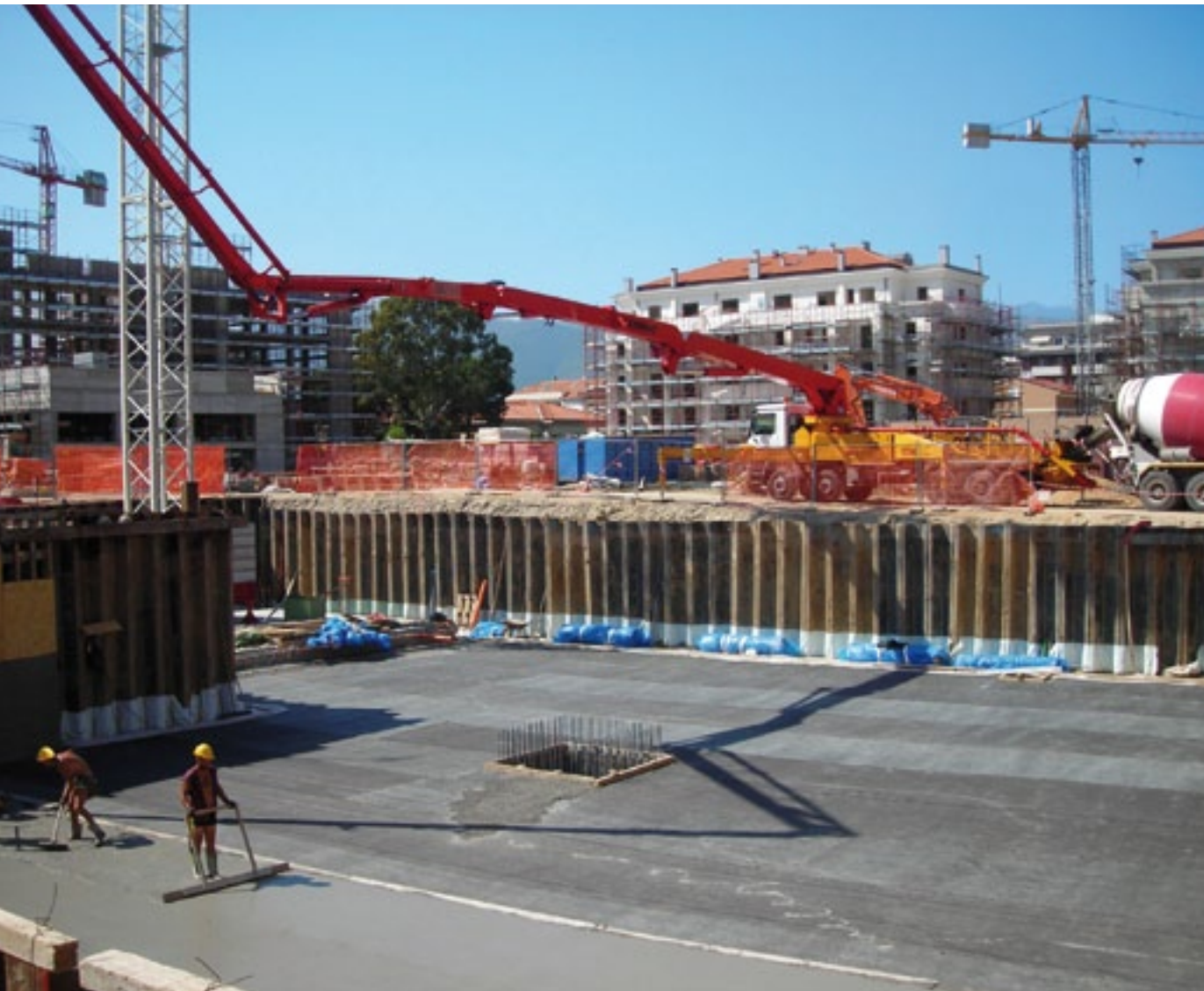
Palancolati - Contenimento scavi
